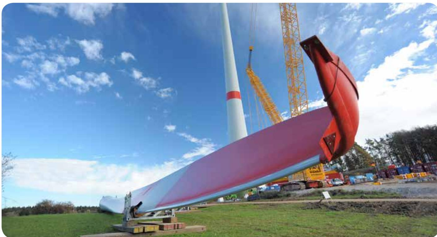
Montage eines Rotorflügels für eine Windkraftanlage bei Alfeld
