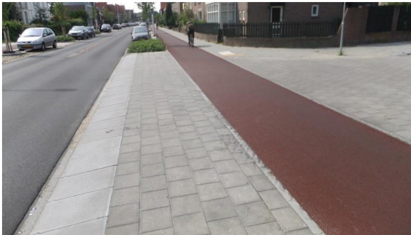
Abb. 22: Beispielmaßnahmen: Anrampung der Straße auf Radwegeniveau, Nullabsenkung von Bordsteinen, Verzicht auf Materialkanten
