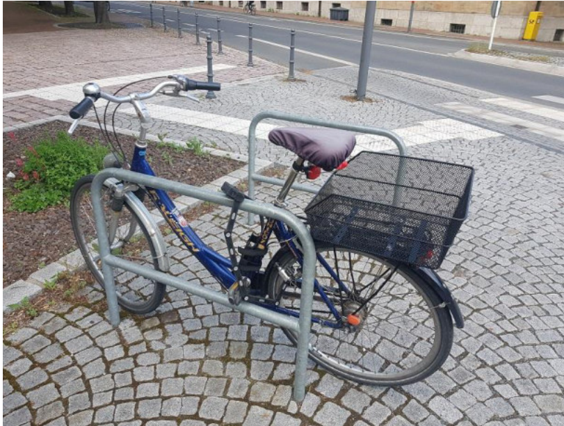
Abb. 77: Anlehnbügel mit Querholm, Ausführung Rundrohr
