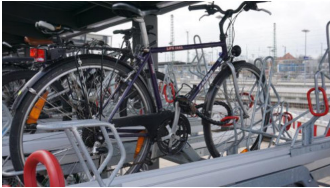
Abb. 74: Radabstellanlage mit Anschließmöglichkeit des Fahrradrahmens
