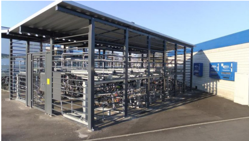
Abb. 80: Sammelschließanlage mit elektronischer Zugangskontrolle
