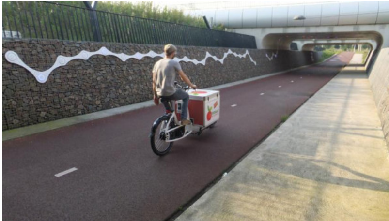
Abb. 17: Kreuzungsfreie Querung durch eine Unterführung (Radschnellweg Nimwegen – Arnheim, Niederlande)
