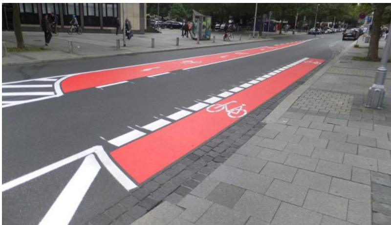
Abb. 31: Intuitive Wegeführung durch Markierungen
