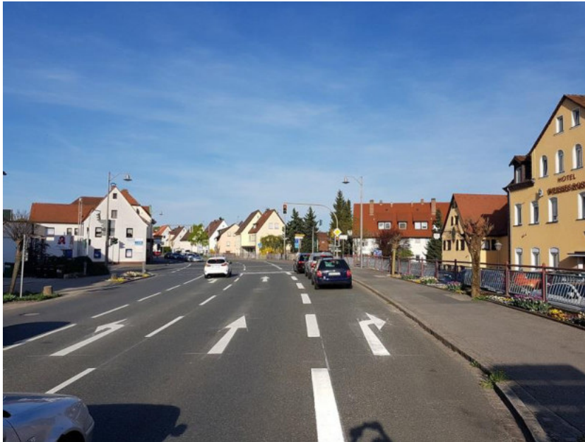
Abb. 27: Die Radverkehrsanlage an der B14 in Behringersdorf ist nicht als solche erkennbar.
