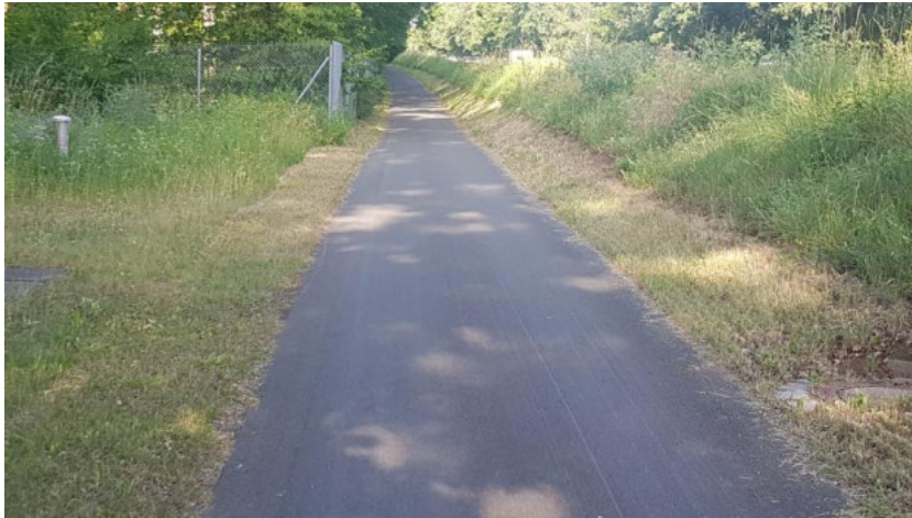
Abb. 90: Die Vegetation ist rechtzeitig zurückzuschneiden. Bereits bei der Planung sollte zusätzlich ein befestigter Randstreifen (Bankette) vorgesehen werden, um ein unnötiges Zuwachsen zu vermeiden.
